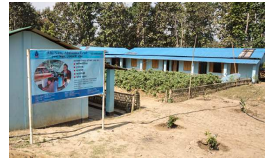
Die Berufsschule in Thanchi mit drei Schulgebäuden, einem Unternehmungsgebäude und einer Weberei-Werkstatt.
