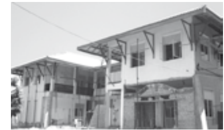
Das Hauptgebäude des Berufsausbildungszentrums im April 2007, kurz vor Abschluss der Bauarbeiten.
