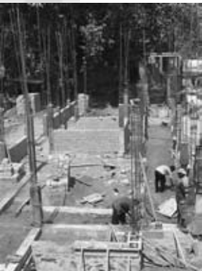
Die Bauarbeiten sollen 2009 abgeschlossen werden.
